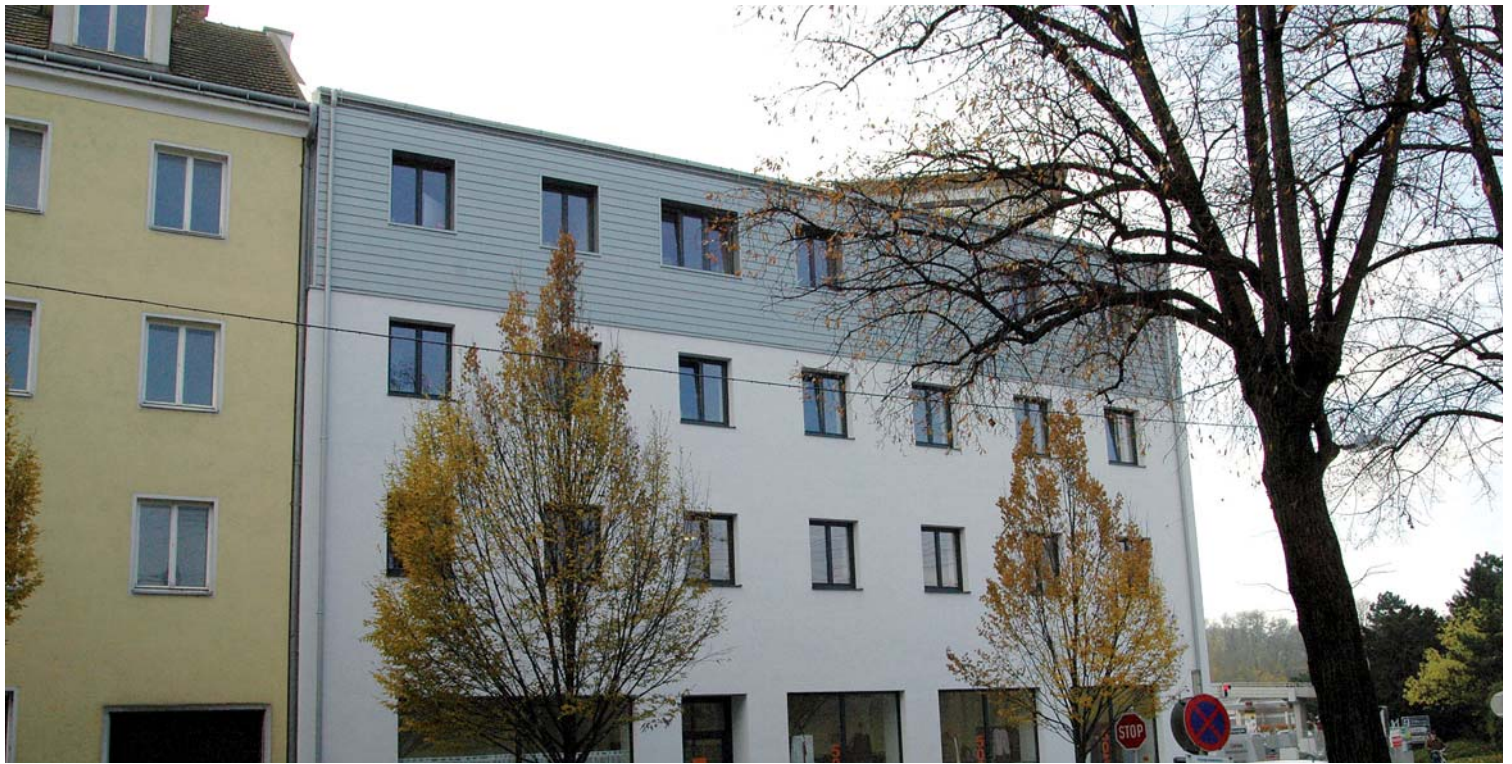
Das neue Caritas Beratungszentrum in der Brunngasse. Die erste Baustufe ist fertig. Derzeit ist dort auch Carla, der Caritas Laden untergebracht.
